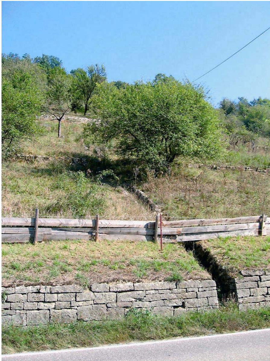
Photo 6: Steinschlagschutz der Straße (bb 2005)
