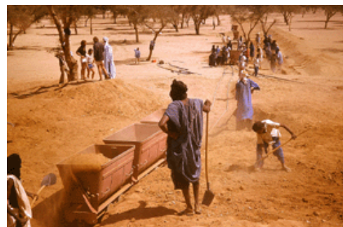
ABBILDUNG 8: Zum Transport wurden Loren und Schienen aufgegebener Bergwerke eingesetzt.
