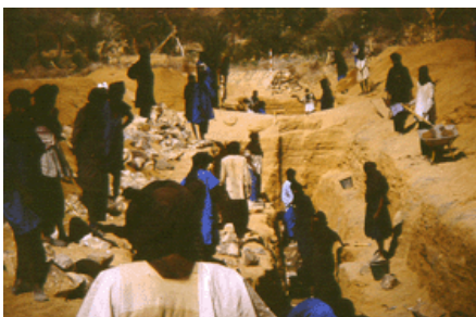
ABBILDUNG 9: Alle Arbeiten wurden arbeitsintensiv ausgeführt um Abwanderung zu verhindern
