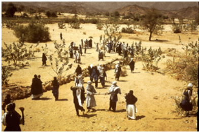
ABBILDUNG 10: Bauwerk zur Ableitung der Flutwelle auf eine Infiltrationsfläche
