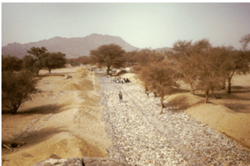
ABBILDUNG 6: Wehr im Fluss bei Iférouane
