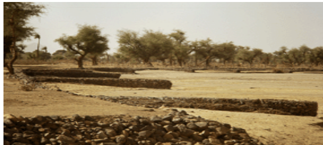
ABBILDUNG 7: Buhnen an den Prallhängen aus Gabionen
